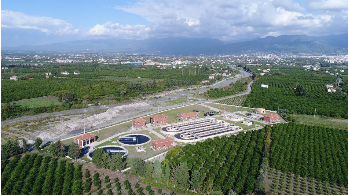
Görsel 2 Dört Yol Atık Su Arıtma Tesisi
