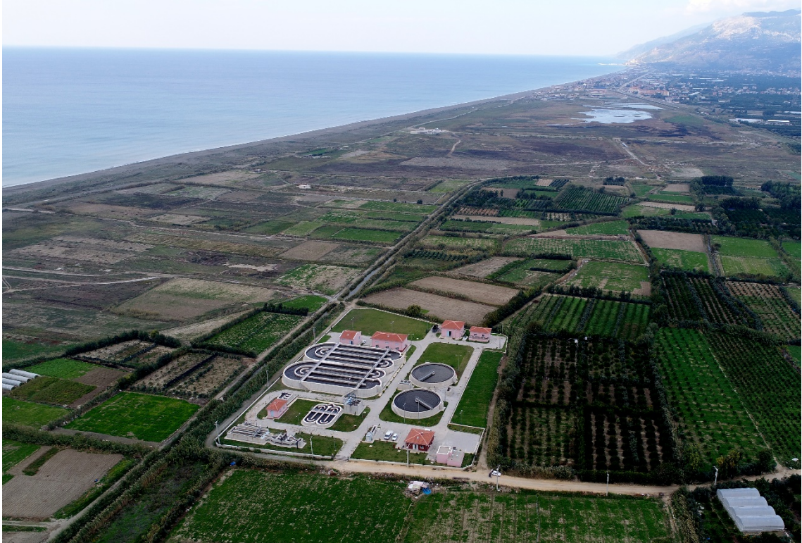
Görsel 1 Samandağ Atık Su Arıtma Tesisi
