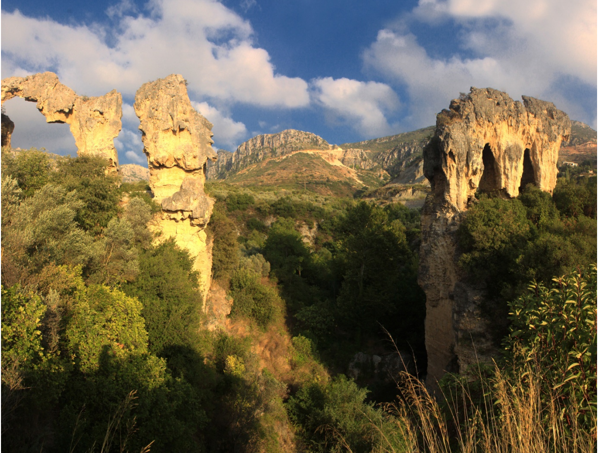
Fotoğraf 3. Kantra Su Köprüsü Kalıntıları
