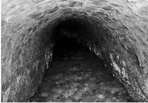
Oygu Tünel görünüm
